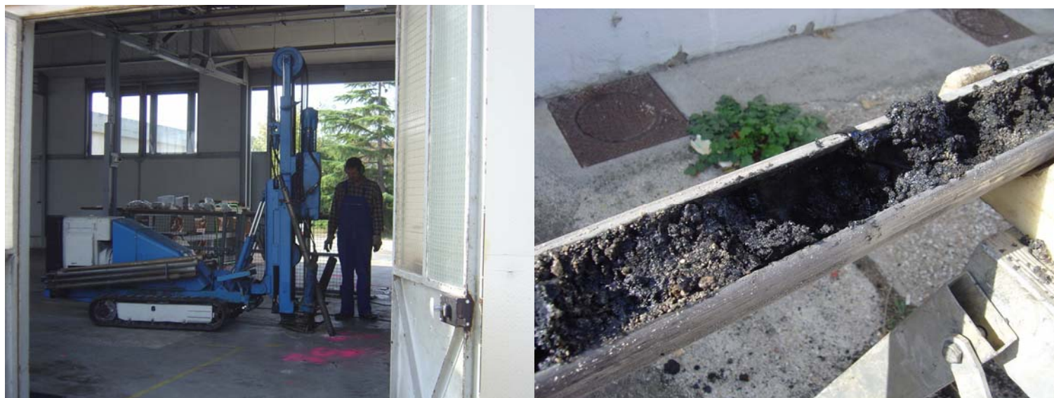
Prélèvement de sol (ici imbibé d'hydrocarbures) par carottage
