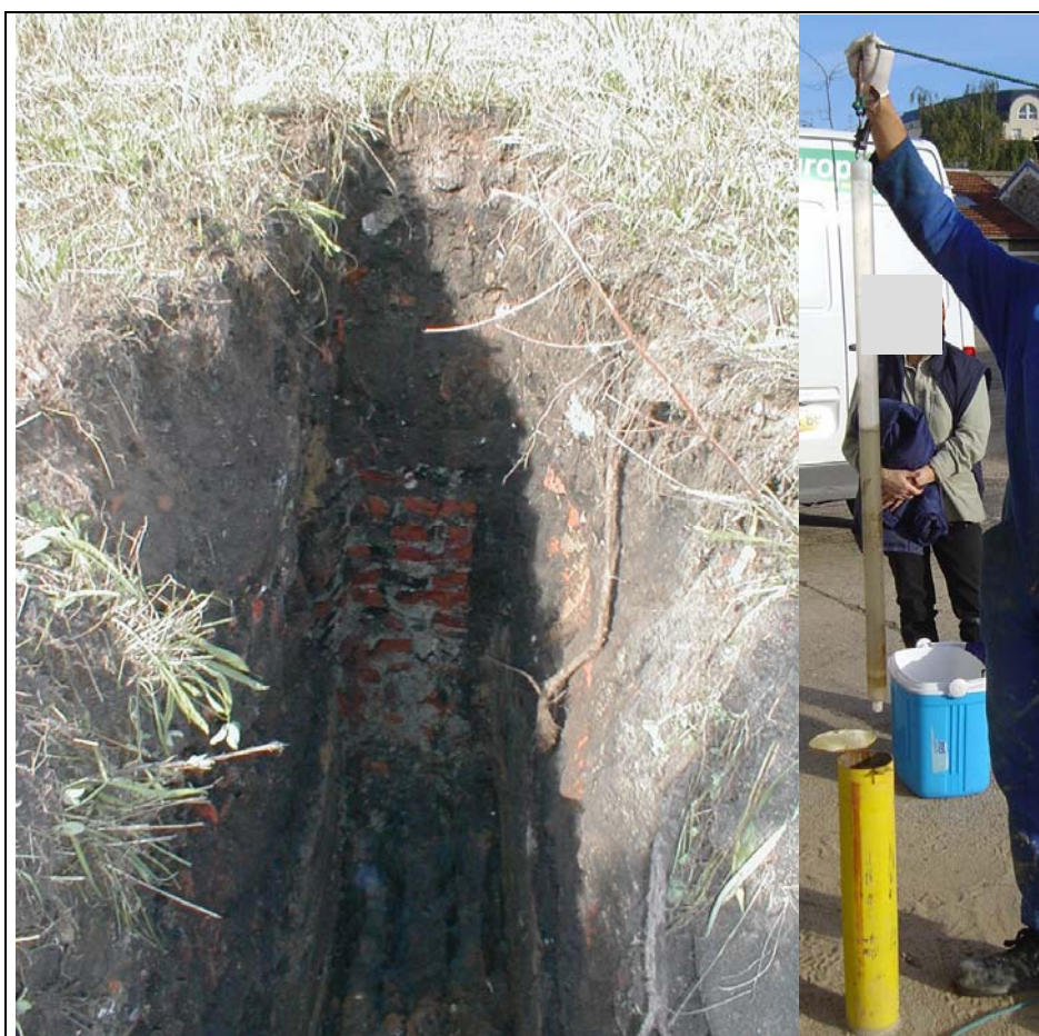
Investigations de site : fouille à la pelle mécanique (gauche), prélèvement d'eau souterraine (droite)
