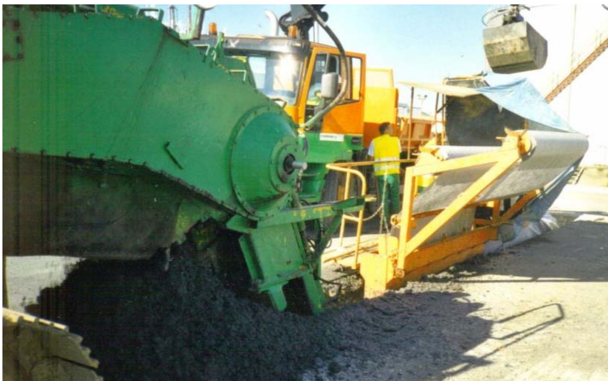
Installation d'une tranchée pour récupération de polluant liquide flottant sur la nappe La tranchée est creusée et aussitôt remplie de gravier, des puits y seront installés pour attirer et pomper le polluant liquide.
