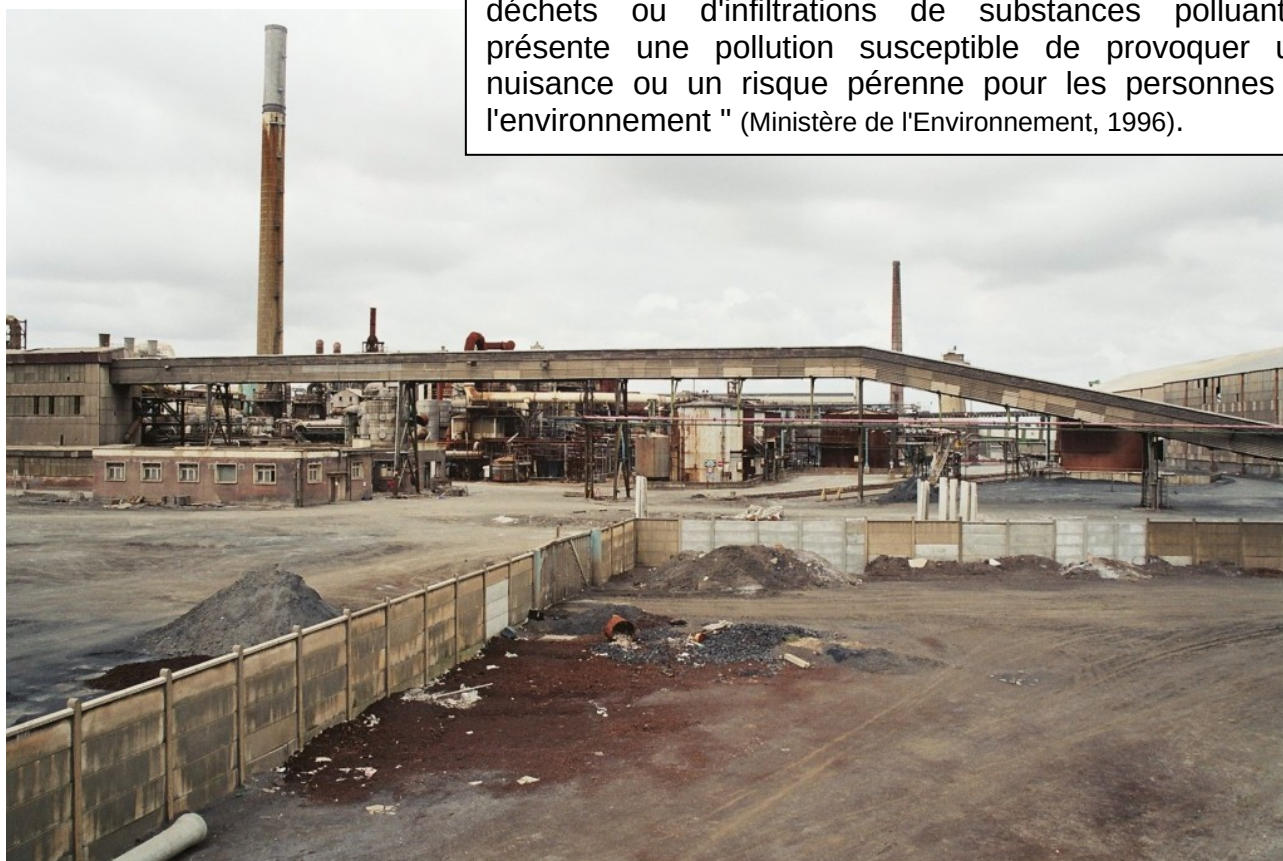
Usine Metaleurop de Noyelles-Godault. Photo Vincent Baumont, avec son aimable autorisation.
